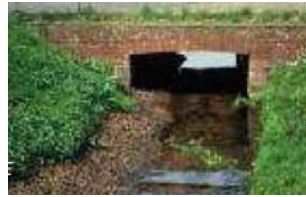
Ecopertuis (Source: "Guide BBP - les fiches techniques - Passages à l'eau", www.biodiversite-positive.fr )
