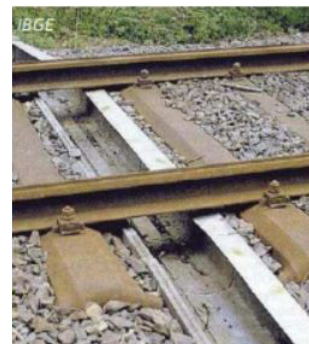
Gouttière pour herpétofaune (Source: "Guide BBP - les fiches techniques - Passages à Faune", www.biodiversite-positive.fr/ )
