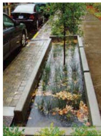
Pied d'arbre décaissé (source : "Infiltrer les eaux pluviales c'est aussi maîtriser les polluants", OPUR)
