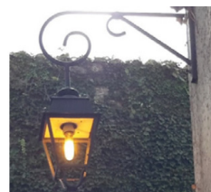
Lanterne à 4 faces avec ampoule verticale et absence de réflecteur
