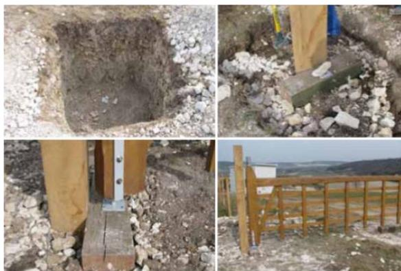
Technique de pose de barrière sans béton dans le boulonnais (Source: "Gestion des pelouses calcicoles sur le territoire transmanche", PNR Caps et Marais d'Opale)
