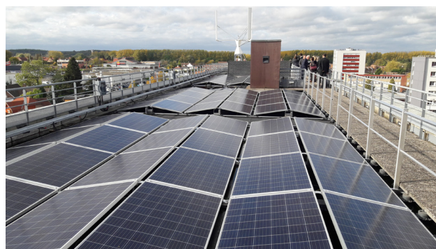
Installation photovoltaïque de 30 kWc de puissance sur la toiture de l'hôtel communautaire de la CABBALR
