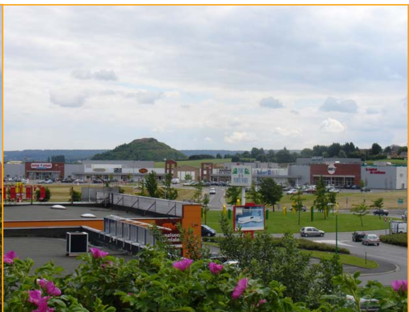
Vue du Centre Commercial de la Porte Nord à Bruay-La-Buissière
