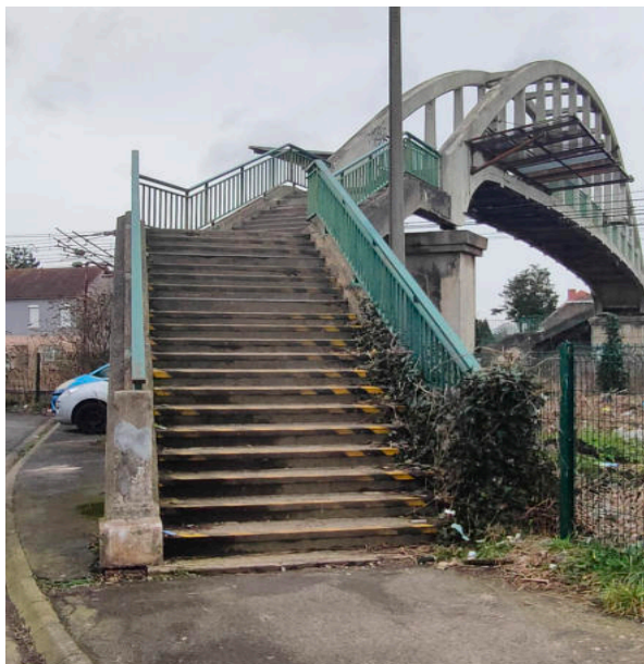
Passerelle en état dégradé, non accessible aux PMR
