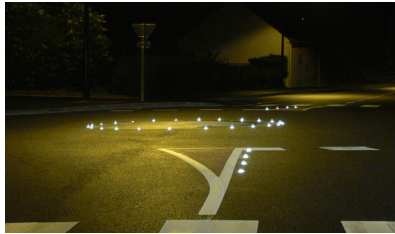
Dispositif rétro réfléchissant (Source : Wikipédia)
