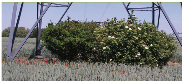
Pied de pylône végétalisé aménagements (Source : « Aménager un pied de pylône : un geste simple, des avantages multiples », RTE et Symbiose)
