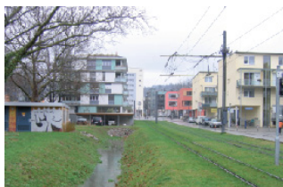
Noue en eau - Quartier Vauban - Friebourg (source: AULAB)
