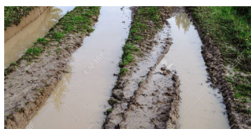
Route avec ornière en eau (Source: 123RF)
