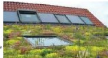
Illustration : Toiture végétalisée gîte de France à Loos-en-Gohelle
