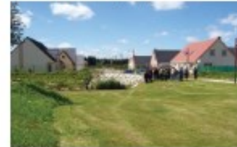
Illustration : Bassin de rétention paysager dans la ZAC (zone d'aménagement concertée) des Garennes, à Arques (62).
